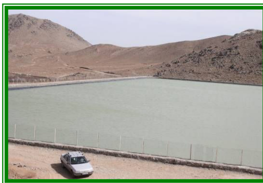
استخر ذخیره آب قهرود
