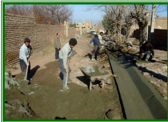
احداث کانال در منطقه مشکات
